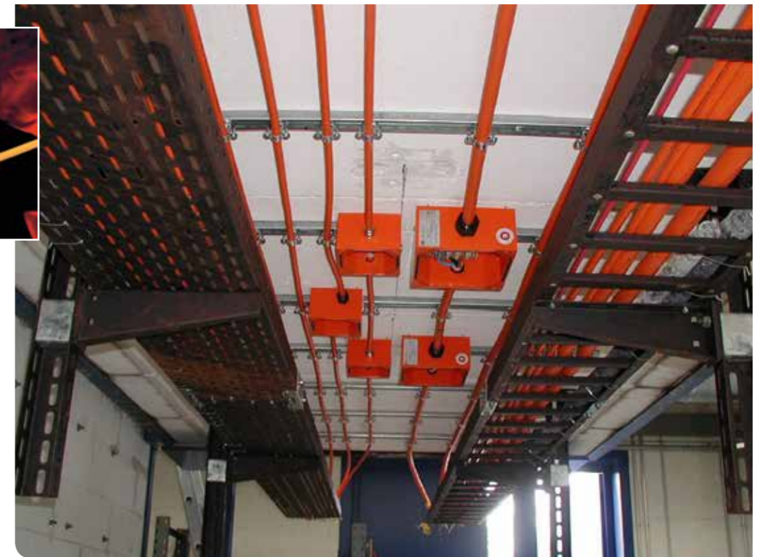
De componenten en materialen waaruit FB-installaties als geheel worden samengesteld, worden nu ook beproefd in combinatie met bluswater.
