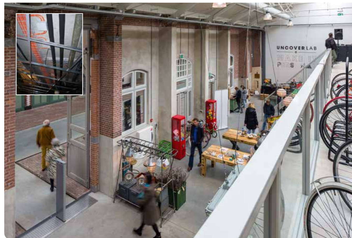
De veiligheidsvoorzieningen in gebouwen moeten ook tijdens brand gedurende een voorgeschreven tijdsbestek hun functie behouden.
